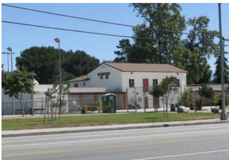
Actual Casa Piscina, recientemente restaurada en espera de nueva piscina.
